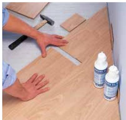
Positionnement de la lame rainurée bouvetée
