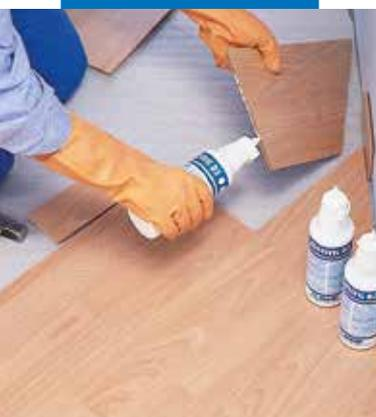
Collage avec Adesivil D3 en rainure de languette
